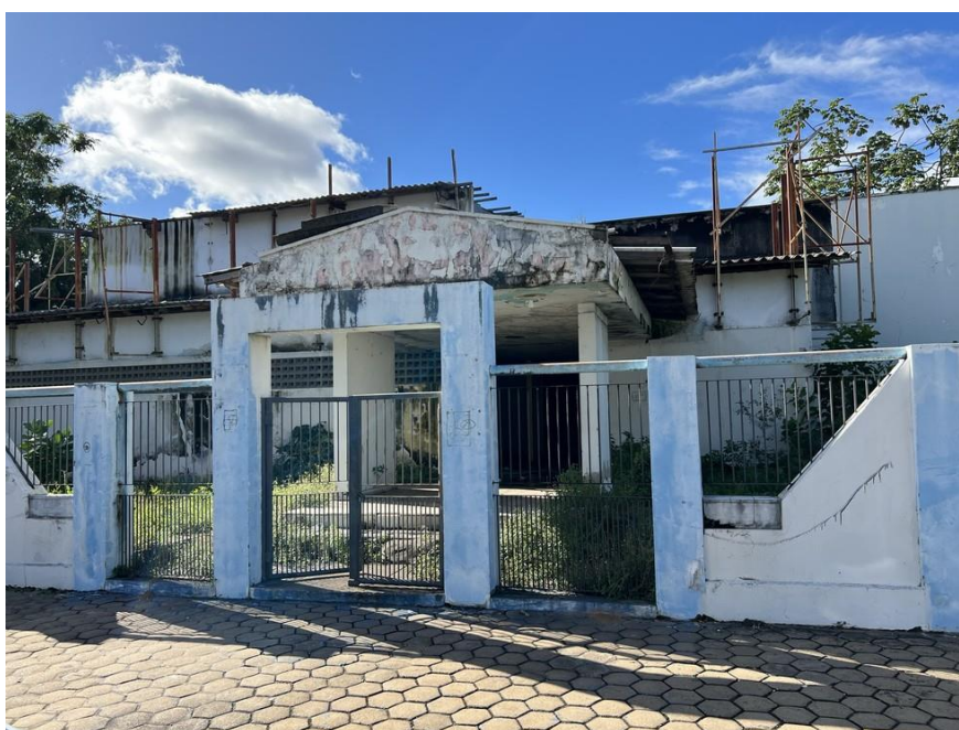
Figura 4 - Fachada do teatro Carlos Gomes
